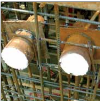
图3 穿墙套管预埋图
