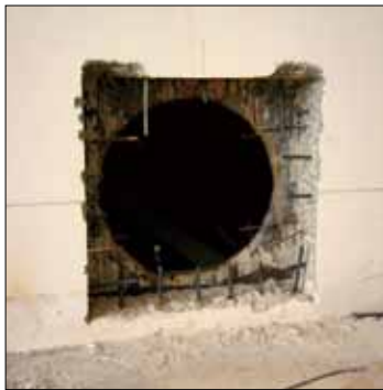
图6 砼二次浇筑完成
