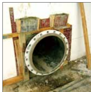
图8 砼二次浇筑完成
