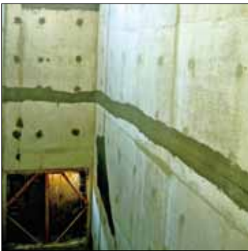
图5 拆除方形模具后的洞口
